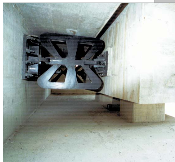
Sopra: Ritegni elastoplastici con lo stesso tipo di dissipatore. A lato: particolare di un accoppiatore viscoso.
